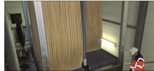
Le délégué SUEZ, a effectué en fin d'année 2022, le renouvellement de 50 % des membranes d'ultrafiltration de la station d'épuration de Carpentras. Ces membranes dataient de 2010, année de mise en service de la STEP.
