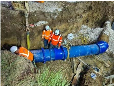
Une importante casse du réseau en diamètre 600 mm à été localisée le 29 avril sur la départementale 183 sous le pont de l'autoroute A7. Sa réparation a nécessité la pose de 120 ml de canalisation en un temps record d'une semaine.
